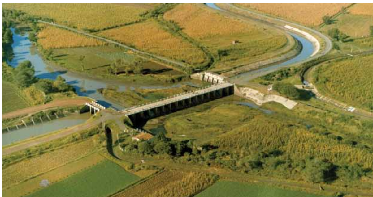
FOTOGRAFÍA TOMADA POR N. PASTELIN MOSTRANDO VISTA AÉREA DE LA PRESA DERIVADORA LOMO DE TORO INVADIDA POR LIRIO ACUÁTICO, EXCEPTO LOS CANALES. YURIRIA, GUANAJUATO, PRESA DERIVADORA LOMO DE TORO, 1972
